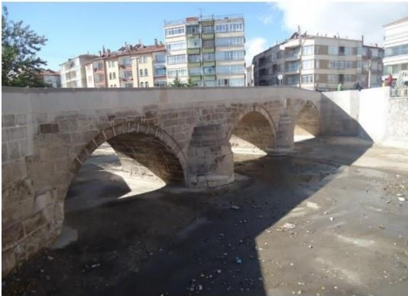
Hassa Köprüsü (B. Uğur)
