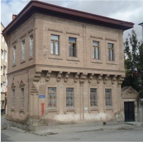
Aksaray Akata Konağı (B. Uğur)
