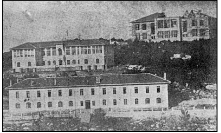
Zonguldak Yüksek Maden Mühendisi Mektebi Alisi Binası
